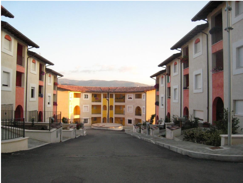
Figura 2 Complesso LA PANORAMICA in L'Aquila
