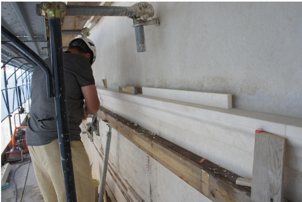
Progetto di riparazione e miglioramento sismico di Palazzo Visconti Ripristino degli elementi lapidei della facciata principale
